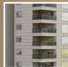
Fachada revestida com massa texturada e gradil nos terraços
