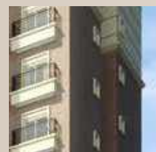
Fachada revestida com pastilha, massa texturada e gradil nos terraços
