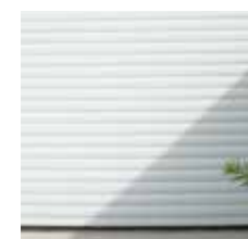
Persianas de enrolar nas janelas dos dormitórios, com previsão de automação
