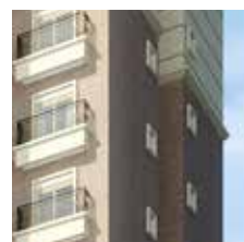
Fachada revestida com pastilha, massa texturada e gradil nos terraços
